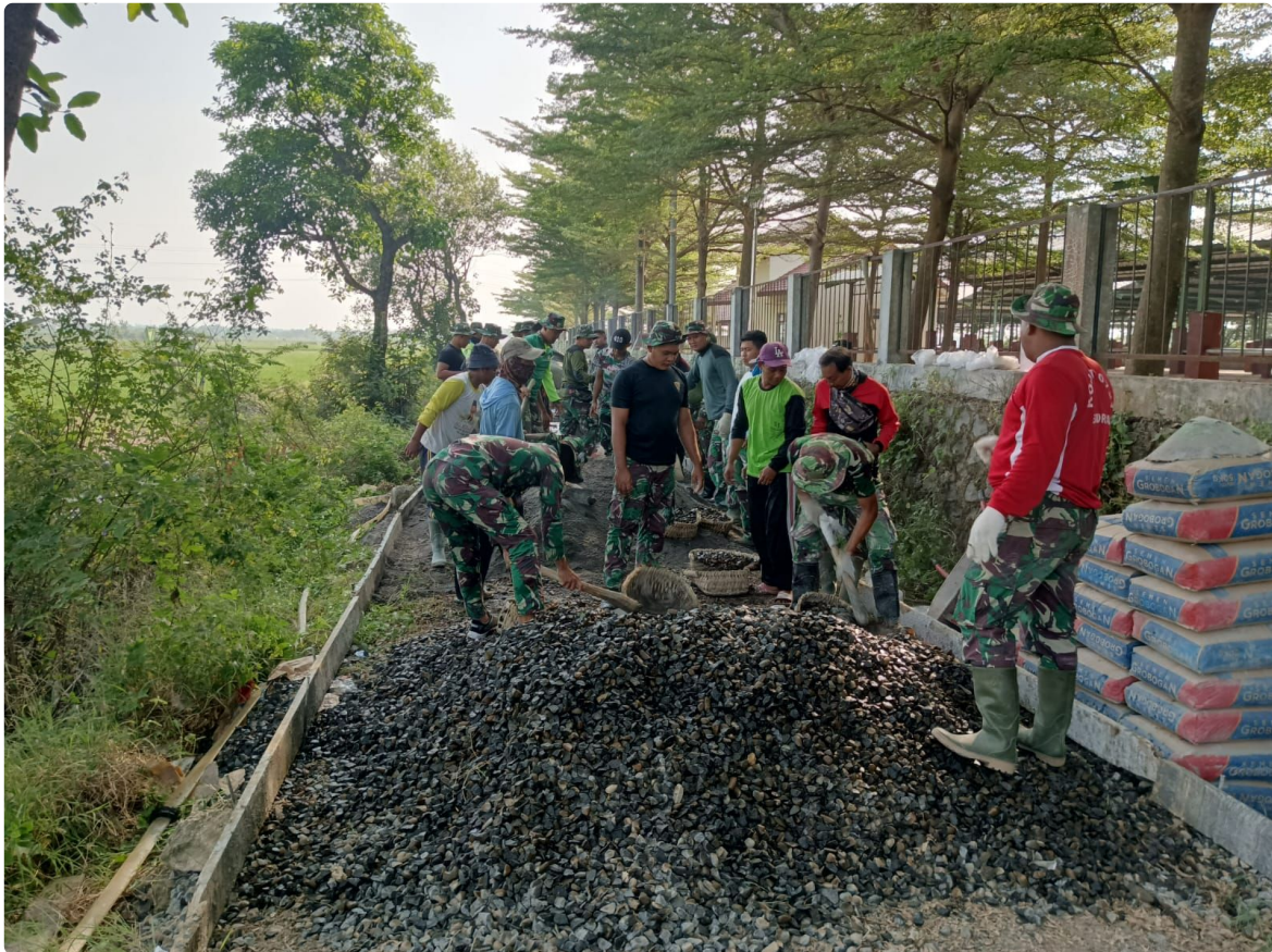
Para personel Satgas TMMMD Kodim 0722/Kudus itu, di lokasi sasaran fisik terlihat antusias untuk mempercepat pengecoran jalan.
