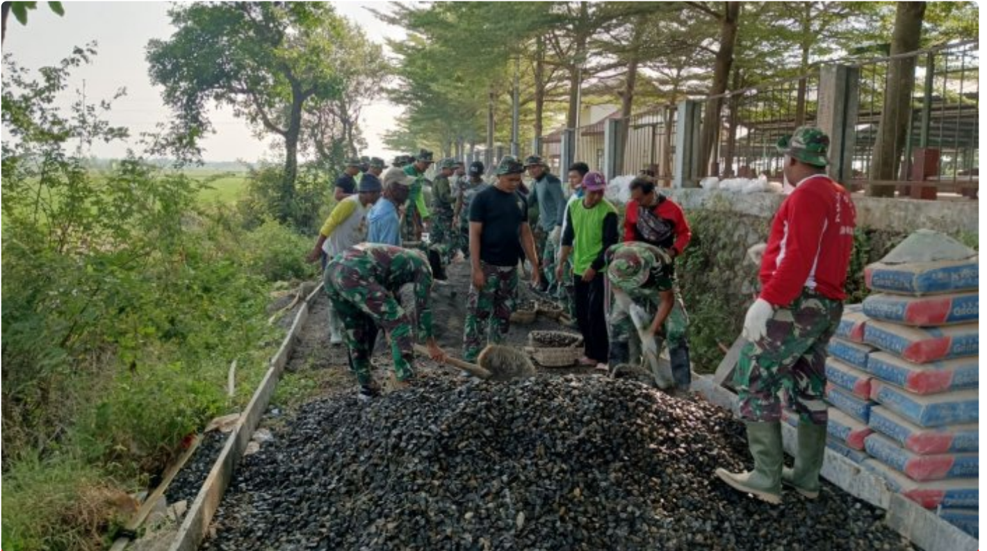
Foto istimewa ( Satgas tmmd reg 116 kebut pengecoran jalan
