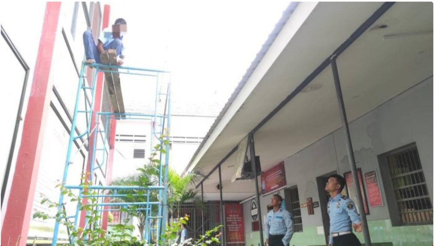
Petugas mengawasi pemeliharaan bangunan
